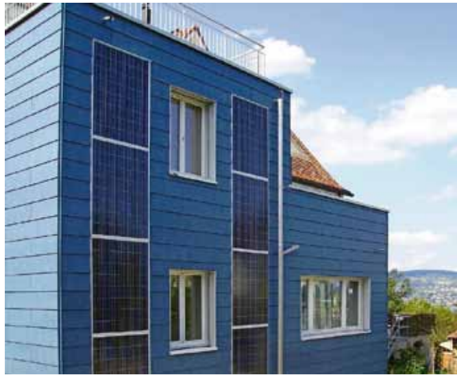
Neben einer kompletten Fassadengestaltung mit Photovoltaik-Modulen kann auch eine integrierte Lösung umgesetzt werden, wie bei einer Holzfassade, deren polykristalline Module 1,3 kWp leisten.
