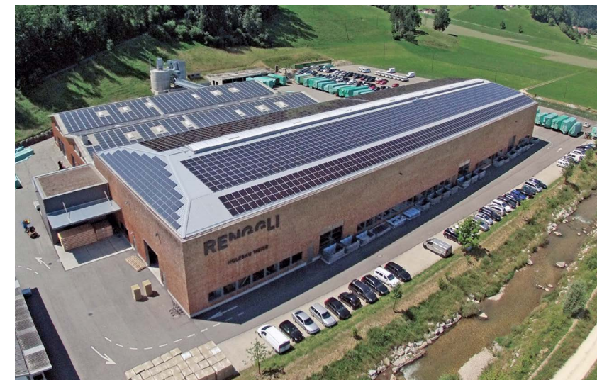
Photovoltaikanlage bei Renggli AG in Schötz.
