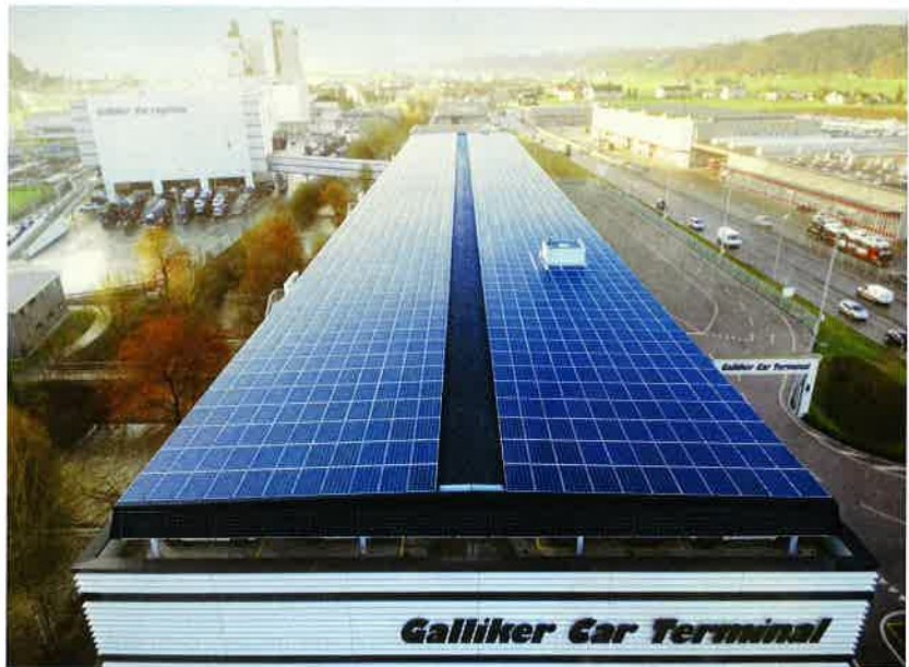
Gutes Beispiel: grossflächige Anlage mit tiefen spezifischen Kosten. So kann der wünschbare PV-Zubau gelingen. Galliker Transport AG in Altishofen LU, 606 kWp. (Bild: Schweizer Solarpreis 2017)
