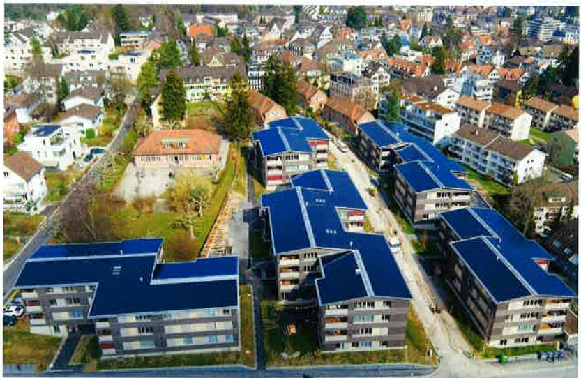
Auch sehr gut: PlusEnergie-Gesamtüberbauung ABZ in Zürich, total 556 kWp. (Bild: Schweizer Solarpreis 2016)
