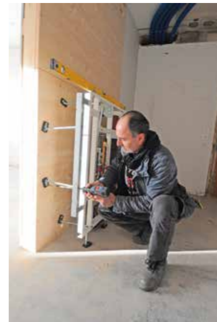
Montage eines Systems an der Stauffacherstrasse in Bern.
