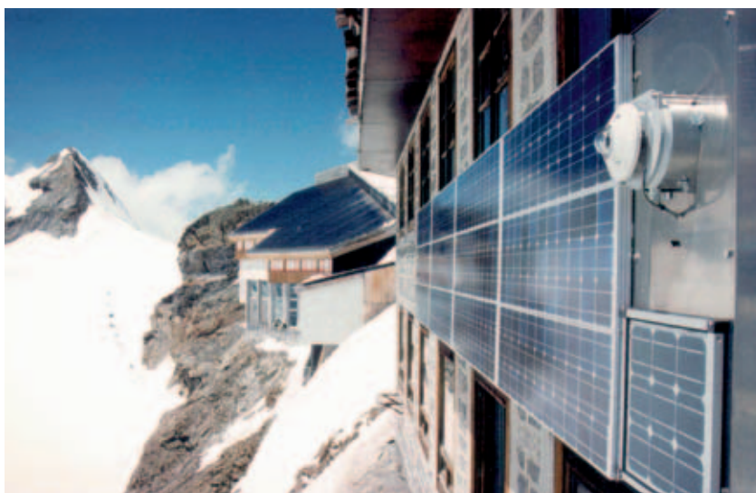
Bild 1 Blick auf die eine Hälfte des Solargenerators der PV-Anlage (1,1 kWp) an der Fassade der hochalpinen Forschungsstation Jungfraujoch (3454 m, etwa 46,5°N). Am rechten Bildrand sind zwei Strahlungssensoren (ein Pyranometer und eine Referenzzelle) zu erkennen.
