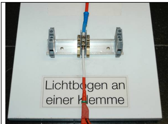
Bild 6: Der Plus-Anschluss der ca. 50 m langen Leitung zum LBD und Wechselrichter wird unmittelbar beim Solargenerator-Simulator über eine Klemme geführt. Bei gelockerten Klemmen und fehlendem LBD können gefährliche Lichtbögen (Bild 7) entstehen.
